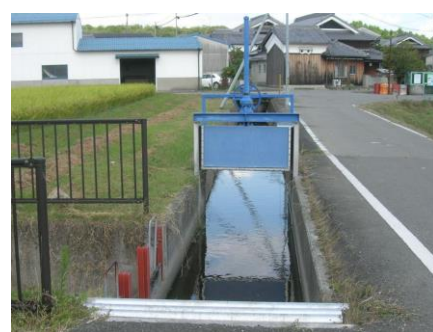
災害対策用水門(青野町)
