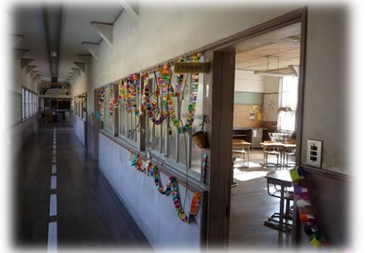
取り壊し前の旧校舎内部
