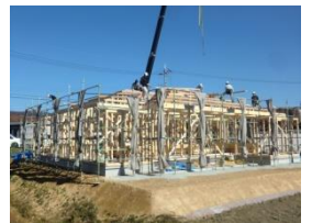
田谷町(上)と小印南町(下)のUターン世帯住宅
