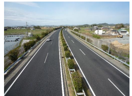
県道 370 号野上河高線高架からの中国道
