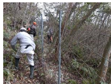
防護柵周辺の草刈りと樹木の伐採、防護柵補修 (画像上&下)
